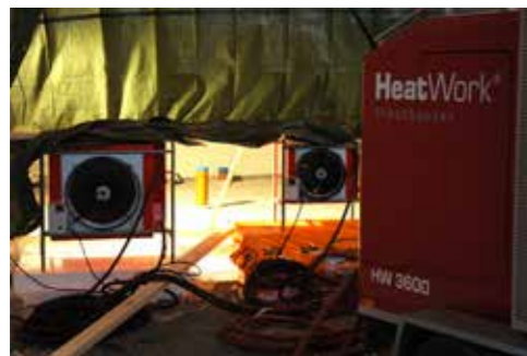
Uppvärmning av depåttält under gjutning av däck
