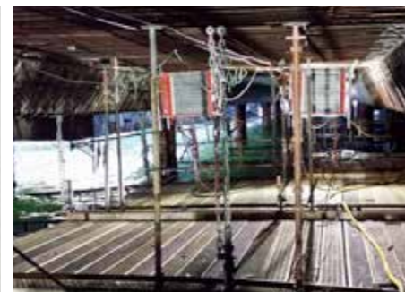
Uppvärmning under renovering av kaj.
