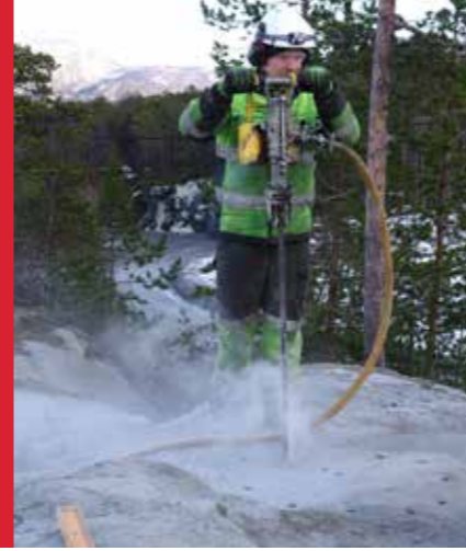
Borring i berg, mastfundament
