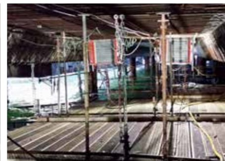
Oppvarming under rehabilitering av kai
