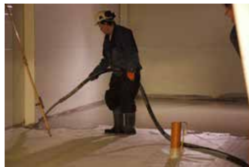
Oppvarming av stillasetelt under støp av dekke.
