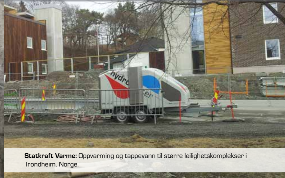
Uttørring av betong før legging av gulvbelegg. Prosjekt Omsorgsbolig, Nilsen og Haukland AS
