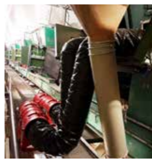
Korn- og kraftfôr siloer varmebehandles
