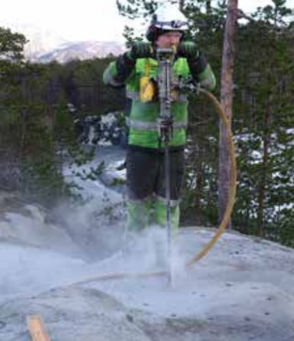
Borring i berg, mastfundament
