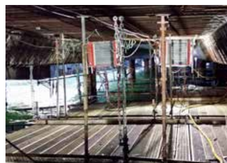
Uppvärmning under renovering av kaj.
