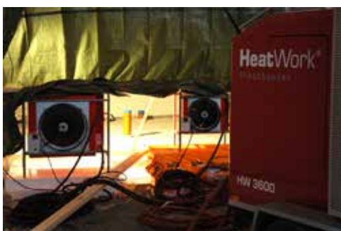
Uppvärmning av depåttält under gjutning av däck
