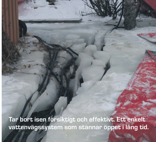
Vattenförsörjningen vid smoltanväxt frös, HeatWork levererar en lösning som säkerställer drift och håller vattenförsörjningen öppen.
