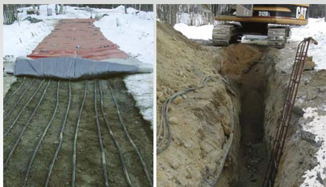
Насос производительностью 3900 л/ч, и температура 100°C, обеспечивают самый оптимальный прогрев.
